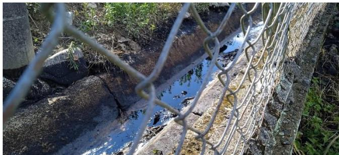
Nota. Canal de desagüe de las aguas lluvias, en este caso salida del crudo
